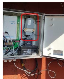
Obrázek 3 Měřicí ústředna s připojením na SENSECOM-GL1 IoT komunikátor
